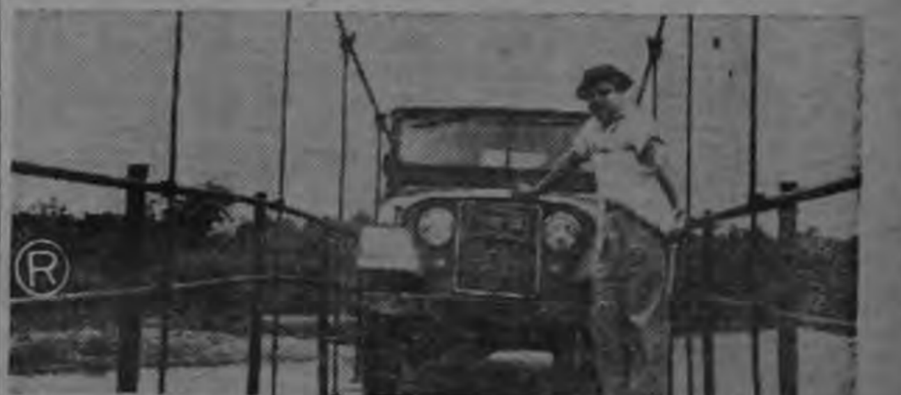
PUENTE SOBRE EL RIO SAVEGRE — El puente colgante sobre el Rio Savegre sirvió para la vía férrea, cuando la Compañía Bananera transportaba miles de racimos de bananos por esa vía. Desaparecido el ferrocarril, fue acondicionado para el paso de vehículos. Aunque puede soportar un gran peso, es tan angosto que apenas da paso a un Jeep. Se encuentra a la entrada de una recta de unos 14 kilómetros debidamente lastreada, que conduce a la población de Quepos.
